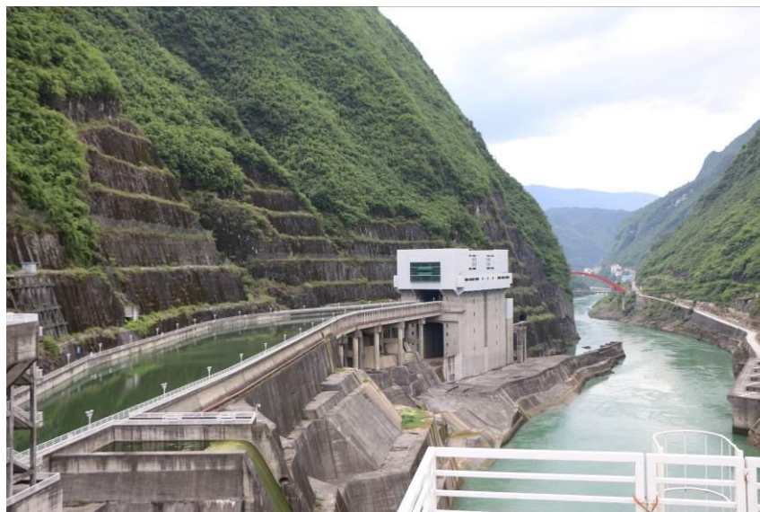
图 3.1.2-4 彭水水电站通航建筑物现状
