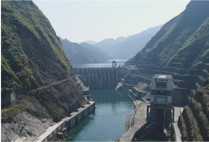
图 3.1.2-2 彭水水电站泄水建筑物现状
