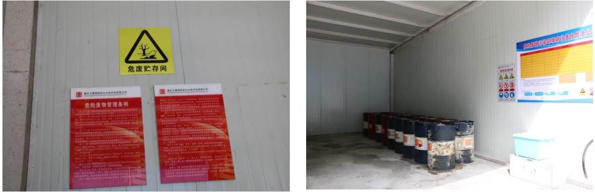
危险废物暂存间现状
