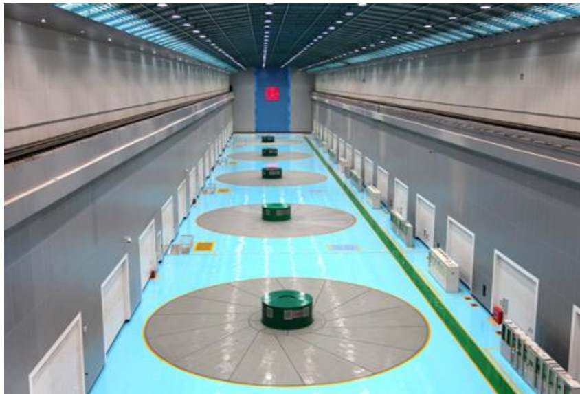
图 3.1.2-3 彭水电站发电厂房现状
