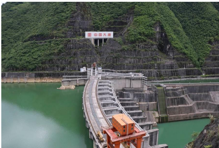
图 3.1.2-1 彭水水电站混凝土重力坝现状
